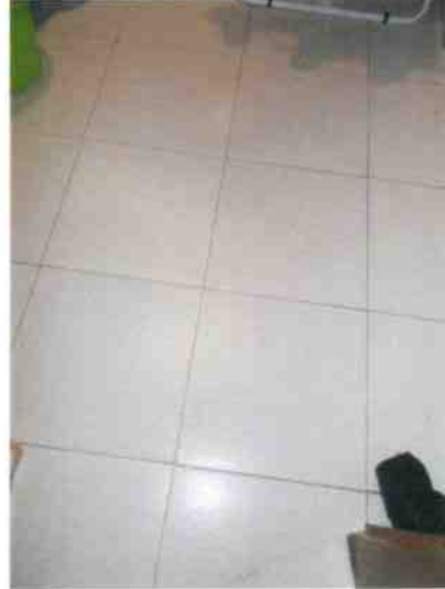
28. Pavimento del bagno
