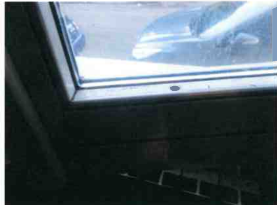
32. Serramento esterno della camera
