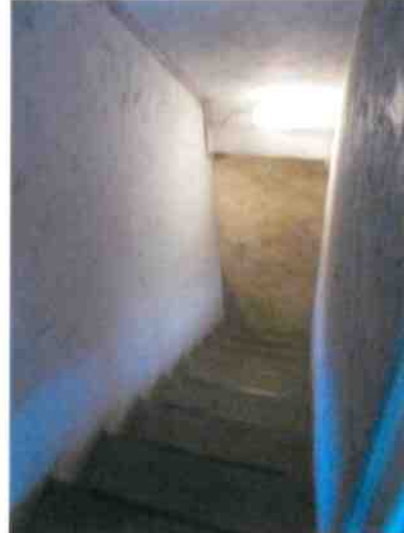
40. Scala di accesso alle cantine
