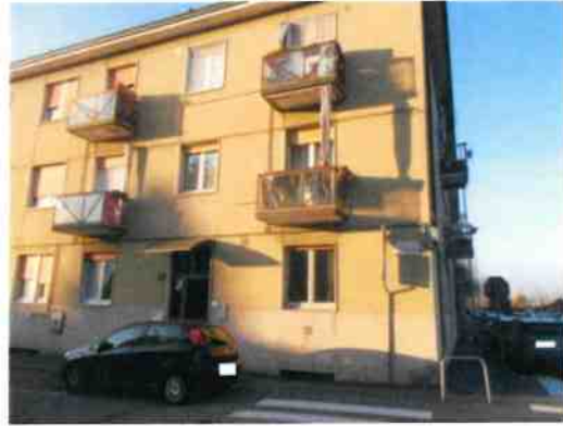
2. Panoramica del fabbricato
