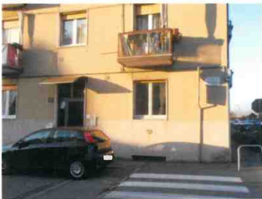
3. Dettaglio del piano terra
